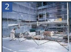
2 仮組みしたステージをクレーンで1.8m~2mほど吊り上げ、吊り材や各斜材間に交差筋かいを取付けます
