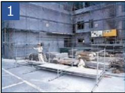
1 スパンピッチに梁枠を配置し、各々2枚の足場板を取付けるなど、ステージを仮組みします
