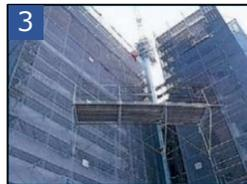
3 組み立てたステージをクレーンで設置場所まで吊り上げます
