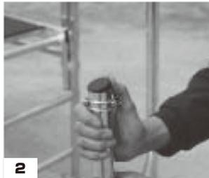
**F.**手摺フレームを、下階フレームの上端部に差し込んでください(写真**4**)。手摺フレームと下階フレームをピンで固定してください(写真**5**)。
