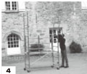
**G.**斜めプレスを手摺フレーム横の上から2番目の穴にはめ込んで取付けてください。このとき、斜めプレスは、下階フレームの斜めプレスと同じ側に取付けてください(写真**6**)。
