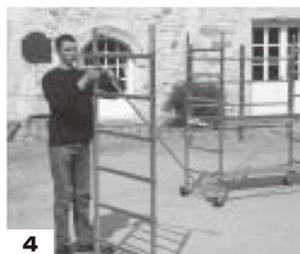
**G.**組み立てた上階フレームを下階フレームに取付けてください。それらをピンにて固定してください(写真**6, 7**)。
