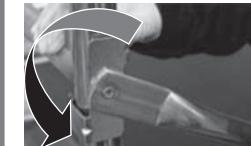
9. 手すりフレーム横の上から 2 番目の穴に斜めプレスをはめ込んで取り付ける。このとき、斜めプレスは下階はしご枠の斜めプレスと同じ側に取り付ける。
