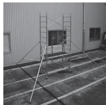
2. 開閉式足場板を下階フレームと上階フレームの間（下から 7 段目の位置）の踏ざんに移動し、固定する。
