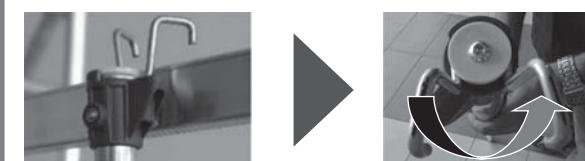
7. WTFDT セットに付属の開閉式足場板を、上階フレームの間（上から 7 段目の位置）の踏ざんに取り付け固定し、幅木も取り付ける。
