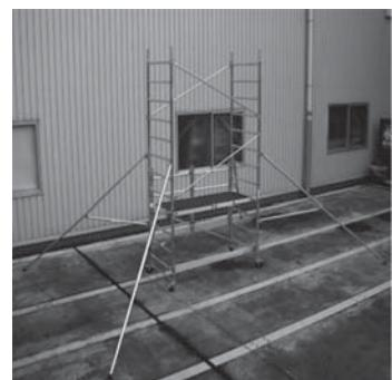
2. 開閉式足場板を下階フレームと上階フレームの間（下から 7 段目の位置）の踏ざんに移動し、固定する。
