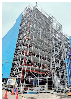
新工場建屋（パース）の完成予想図（上）と建設中の建屋、足場はアルインコの看板製品「アルバトロス」（新型くさび緊結式足場）
