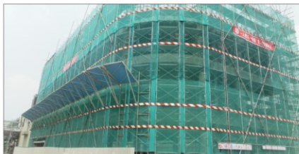
门式外墙脚手架防护架照片
