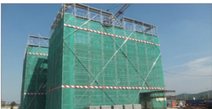
脚手架外侧使用先行扶手架
