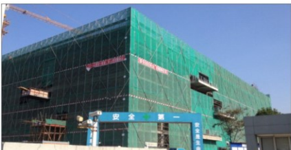
门式外墙脚手架效果图
