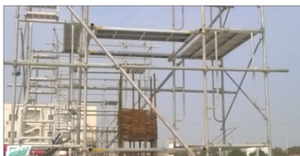
独立柱的施工
